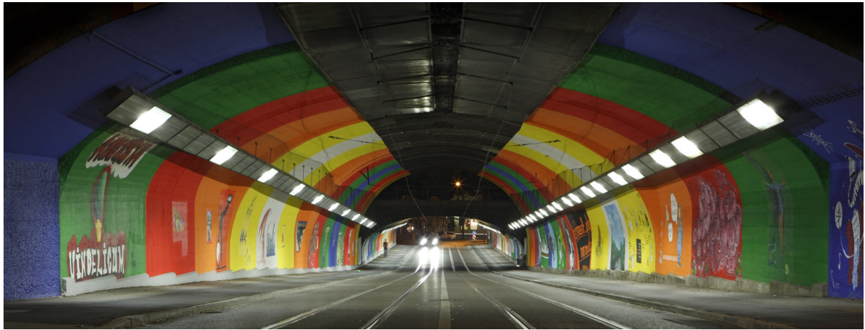
Augsburger Kunsttunnel Pferseer Unterführung – Foto: Norbert Liesz 2012
